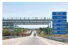
Autoestrada SEM opção de pagamento manual
